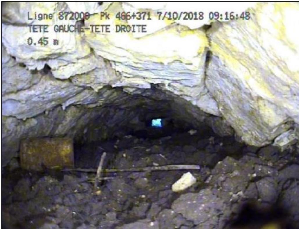
Figure 10 | Photographie de l'ouvrage hydraulique de traversée (OHD) H3 au PK 466,370. Source : SNCF
