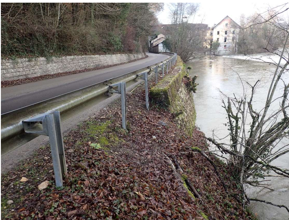
Photo N° 2 : vue de l'extrémité amont (côté Geneuille)
