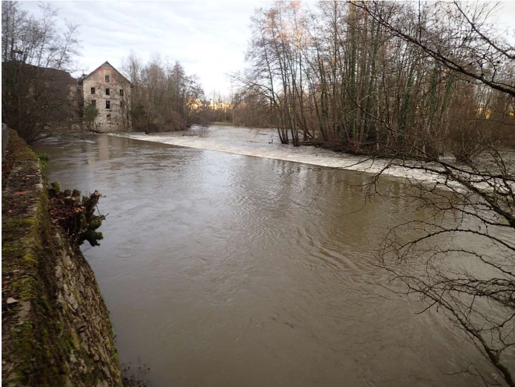
Photo N° 7 : environnement aval de l'ouvrage
