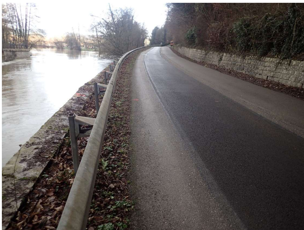
Photo N° 1 : vue de la chaussée depuis Bussières (70)
