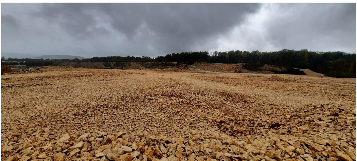
Illustration 4 : Terrain situé au Nord où les travaux de découverte des matériaux altérés sont achevés
