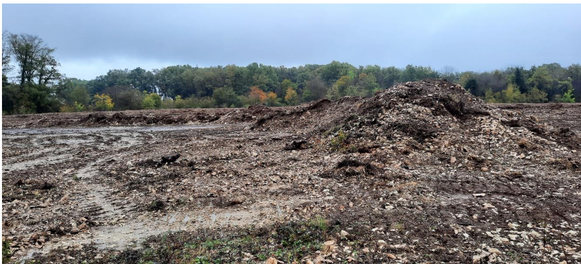
Illustration 3 : Stockage provisoire de la terre végétale avant reprise pour régalaage sur les remblais
