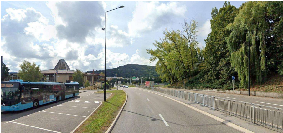
RN57 SENS NORD -> SUD – SITUATION ACTUELLE (SOURCE : EGIS) A DROITE : PLANOISE ; A GAUCHE : MICROPOLIS
