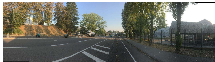
RN57 SENS SUD -> NORD – SITUATION ACTUELLE (SOURCE : EGIS) A GAUCHE : PLANOISE ; A DROITE : MICROPOLIS
