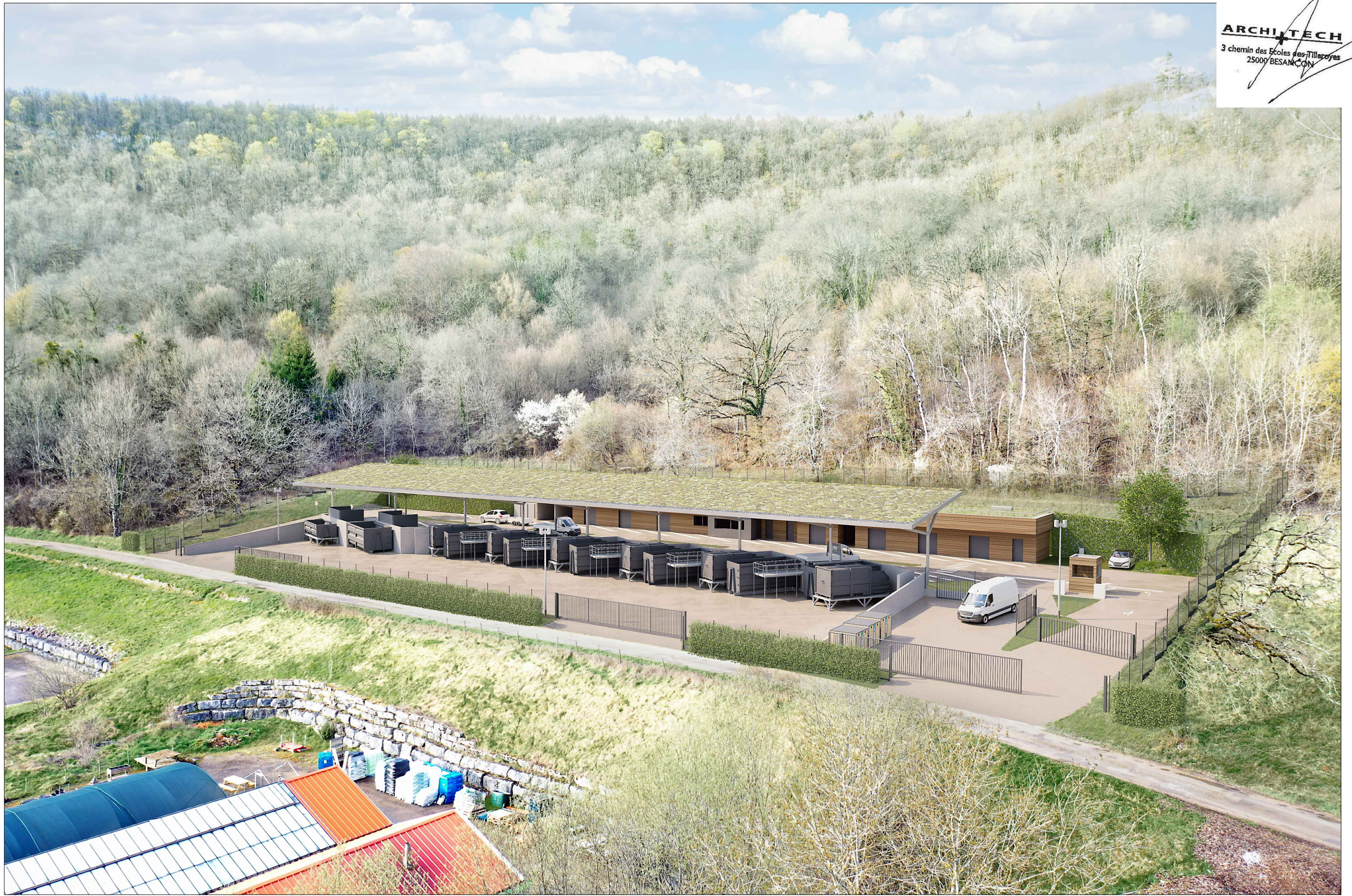
Vue Sud - drone
