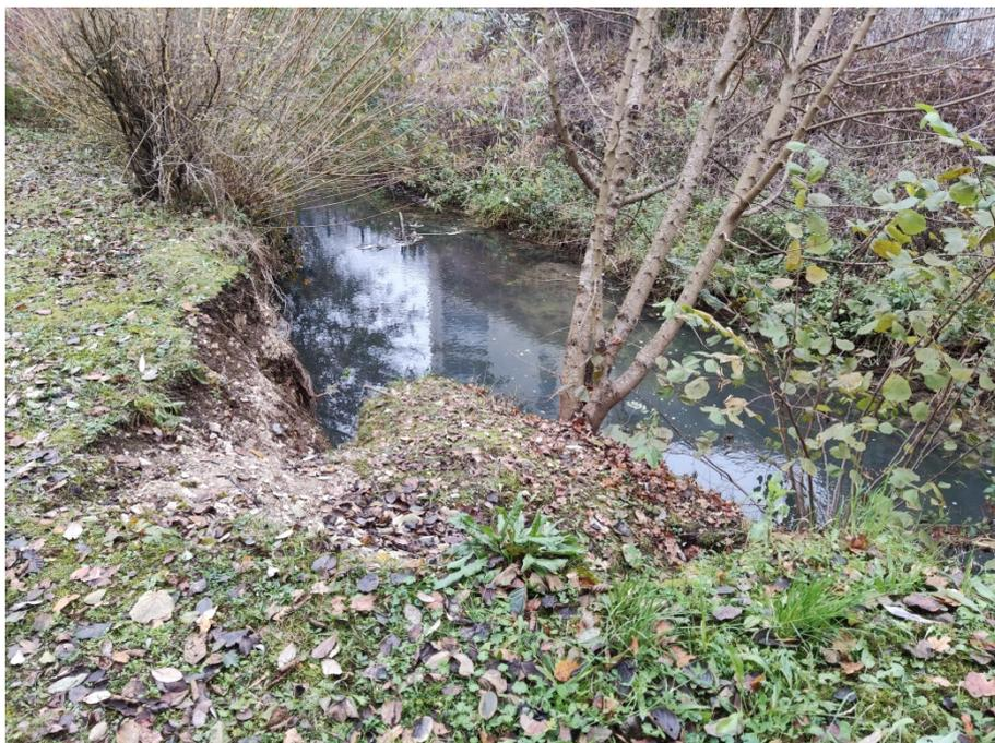
Figure 7 : Photographie du site de travaux en novembre 2021 – anse d'érosion avec effondrement
