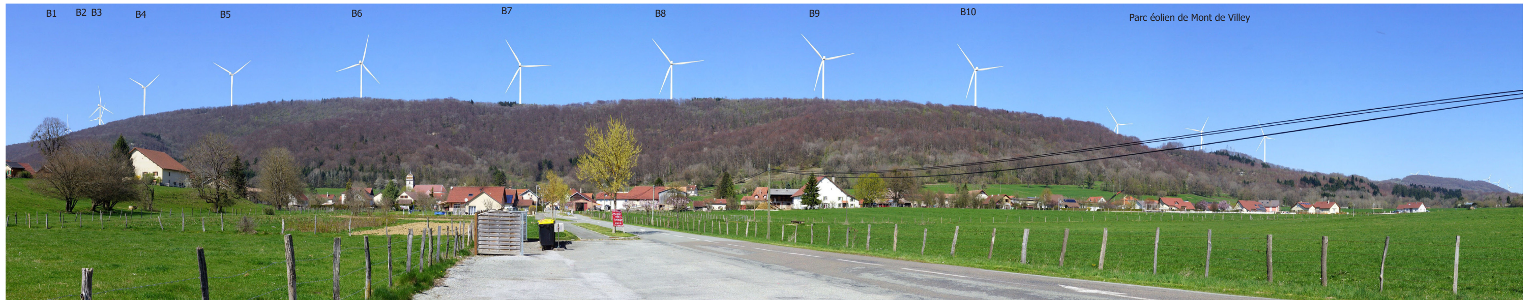
Variante B : 10 éoliennes dont 2 éoliennes ouest d'une hauteur totale de 175 m et décalées vers le nord, et 8 éoliennes d'une hauteur totale de 180 m localisées sur la même ligne que les éoliennes existantes (panorama dans un angle de 120°)
