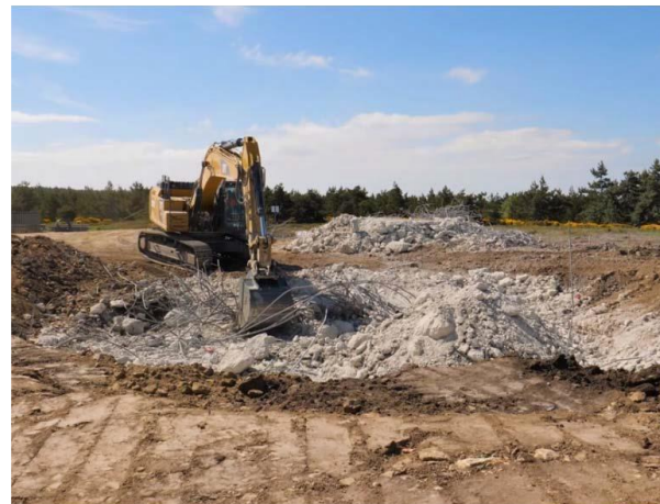
Illustration 7 : Démantèlement d'une fondation (Source : Actu-Environnement)
