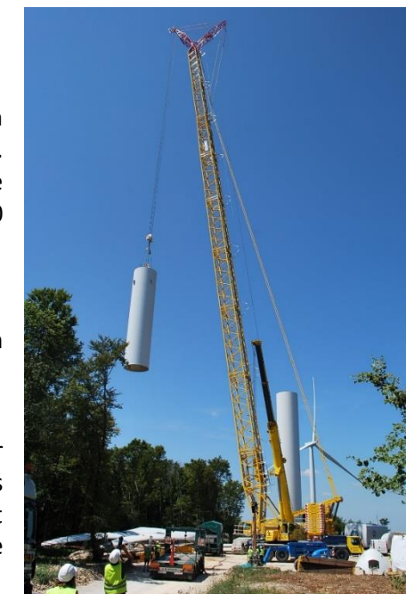
Illustration 15 : Montage du mât de l'éolienne (Monts du Lomont)
