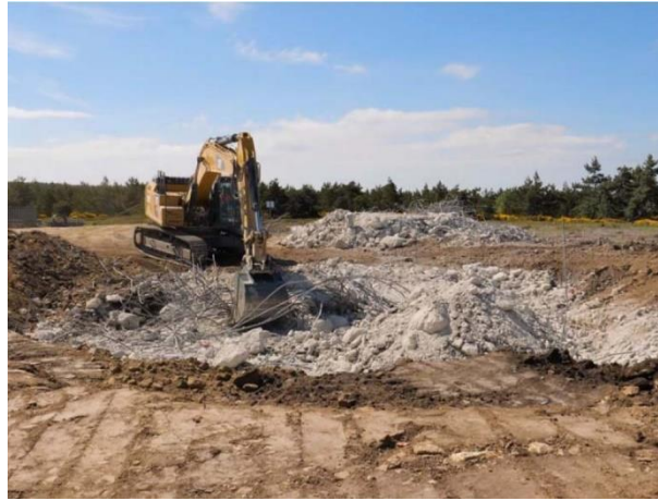
Illustration 13 : Démantèlement d'une fondation (Actu-Environnement)
