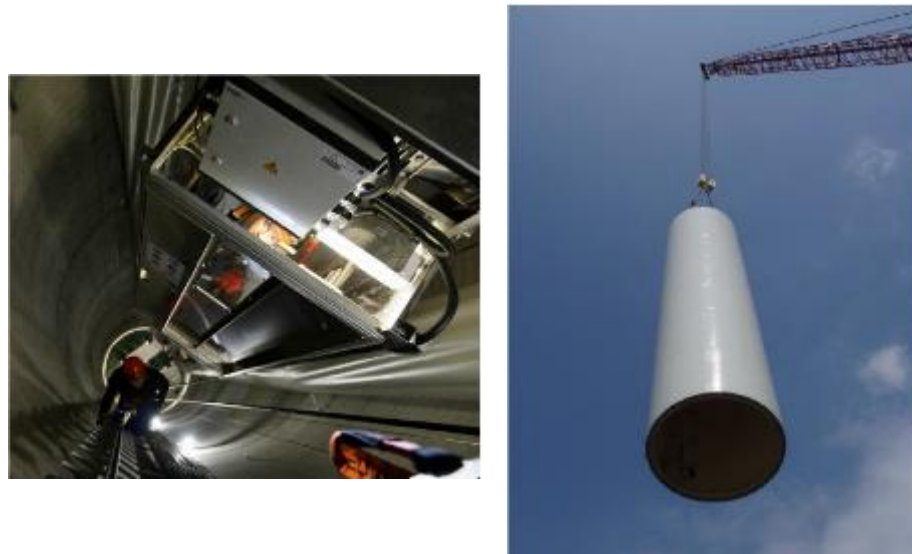
Illustration 6 : Le mât (intérieur et tronçon de mât en phase d'installation)
