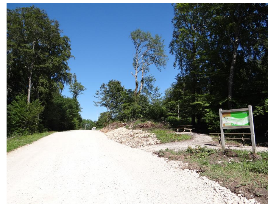
Illustration 12 : Accès ouest au parc éolien du Lomont
