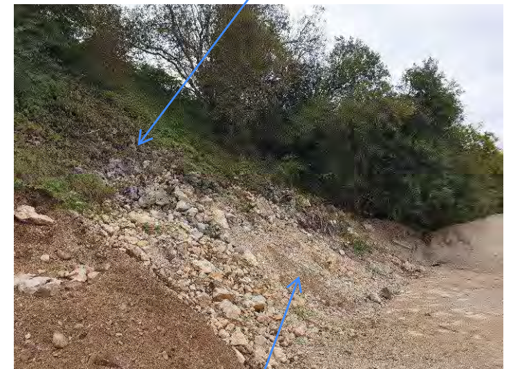
Enlèvement du stock 4 appuyé initialement contre le merlon ©LPO BFC
