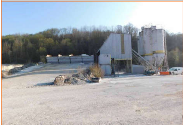
Centrale à béton
