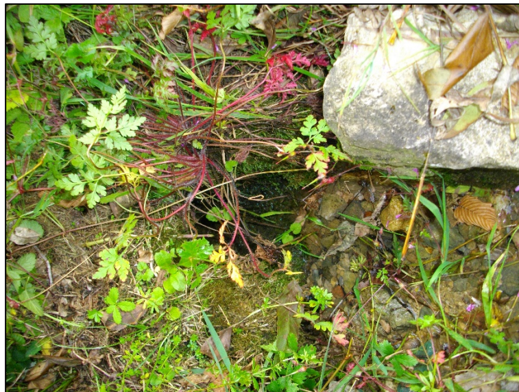
Figure 16 : Vue sur le trop-plein de l'ouvrage
