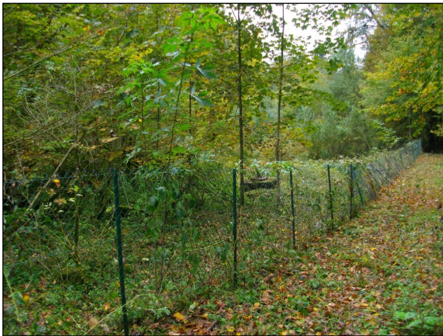
Figure 11 : Zone clôturée autour des ouvrages de Blanchetterre
