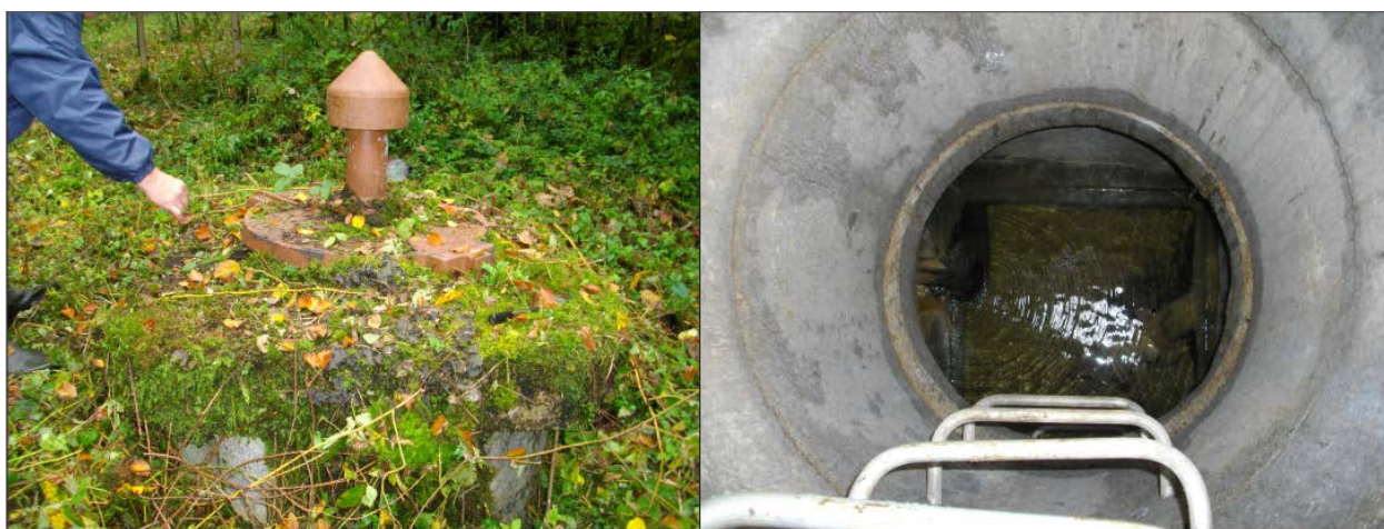
Figure 8 : Vues sur l'ouvrage de Blanchetterre amont
