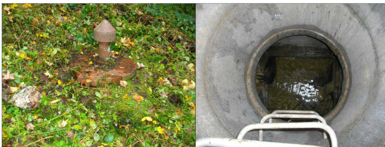
Figure 9 : Vues sur l'ouvrage de Blanchetterre aval
