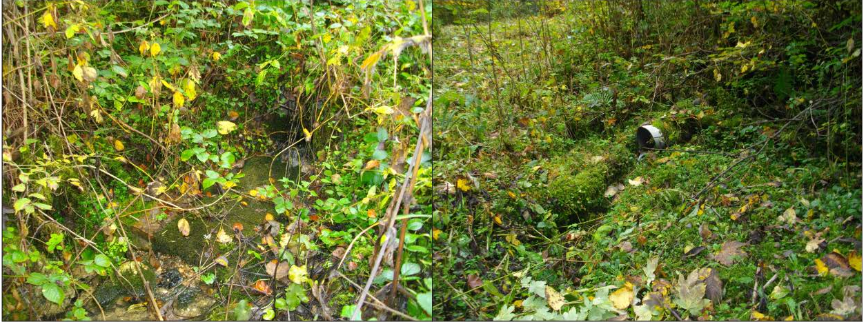
Figure 10 : Vues sur les trop-pleins des ouvrages de Blanchetterre
