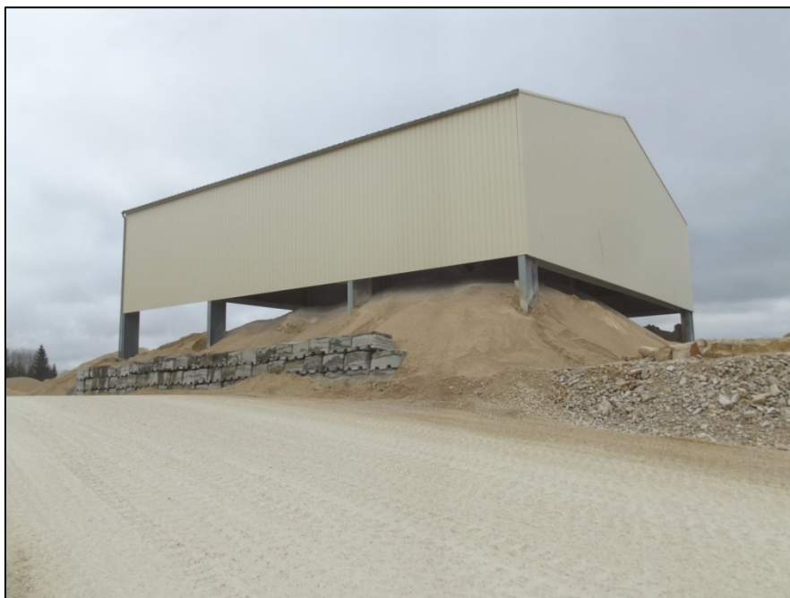
Photographie 5 : Vue sur le stock de sable abrité sous hangar
