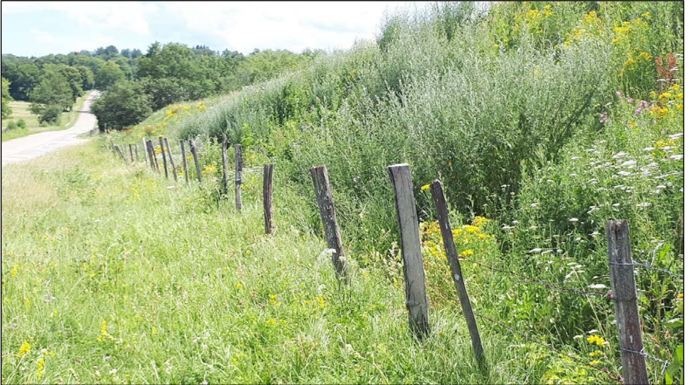
Photographie 7 : Grillage barbelé et merlon en limite Nord du site (RD6)
