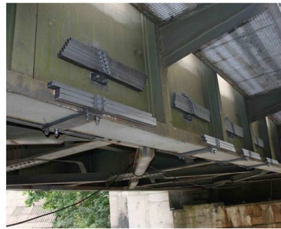
absorbeur sur platelage
