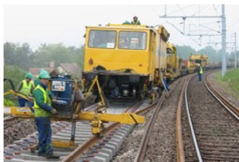
Longs Rails soudés sur traverses béton
