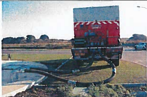
Plateforme d'aspiration sur une réserve d'eau enterrée équipée de deux colonnes d'aspiration de 100 mm
