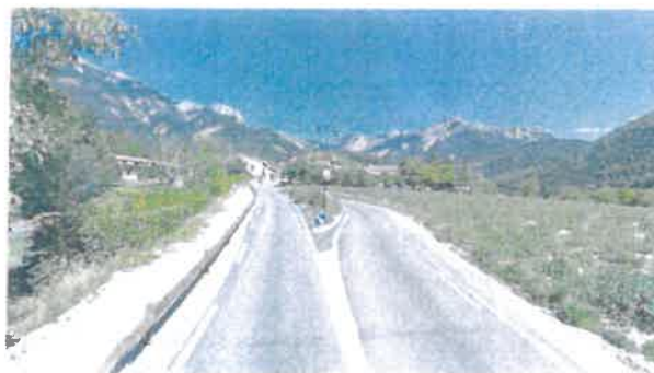
Ilot central en entrée de village
