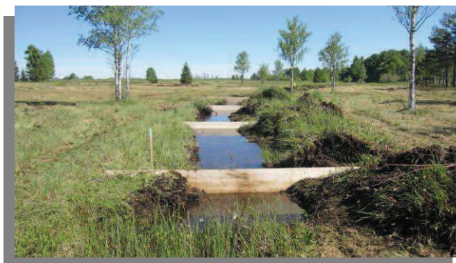
Comblement d'un fossé dans une tourbière – Photo CC Frasne - Drugeon
