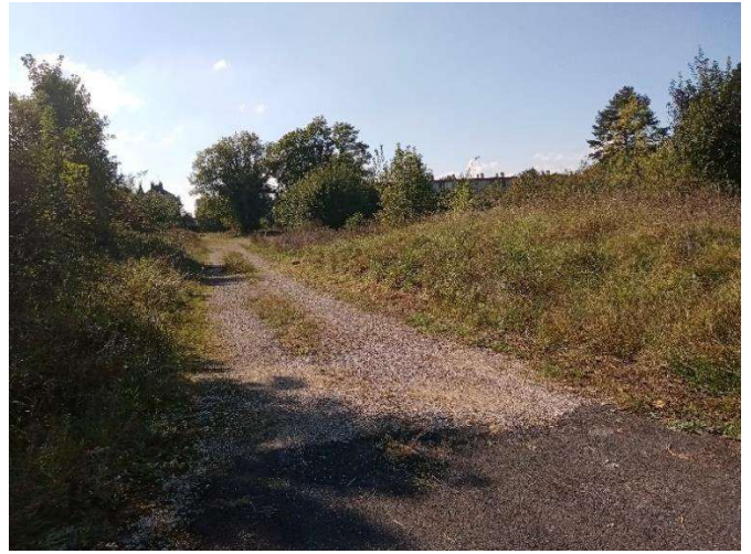
B- Voiries en graviers
