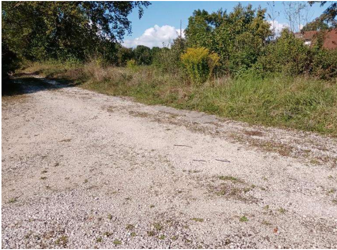
A- Voiries en graviers
