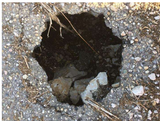
L- Cavité karstique observée sur le chemin au centre de la zone d'étude (09/05/2022)
