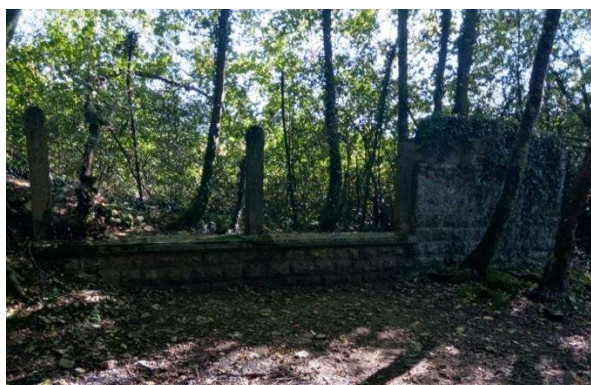
E- Mur en pierre séparant les parcelles DY282 et DY171
