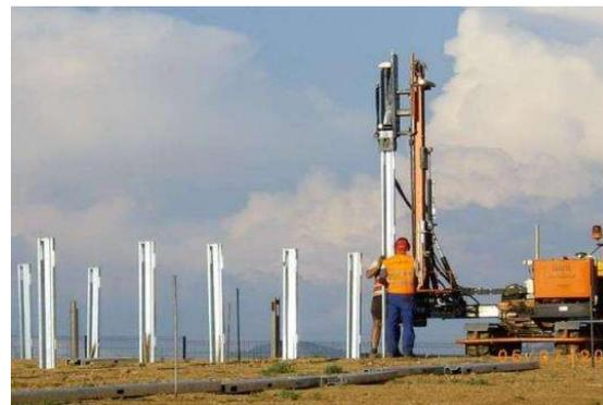
Figure 4 : Exemple de batteuse hydraulique
