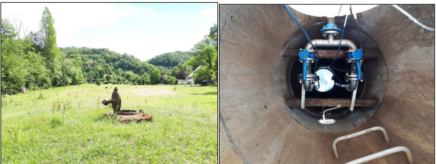
FIGURE 6 : VUES EXTÉRIEURE ET INTÉRIEURE DU PUIS PRÉ DU MOULIN
