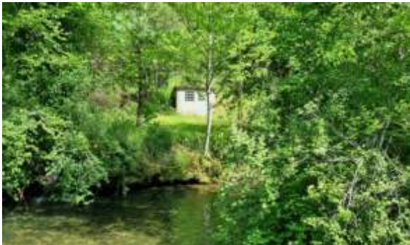
La station de traitement - rive droite
