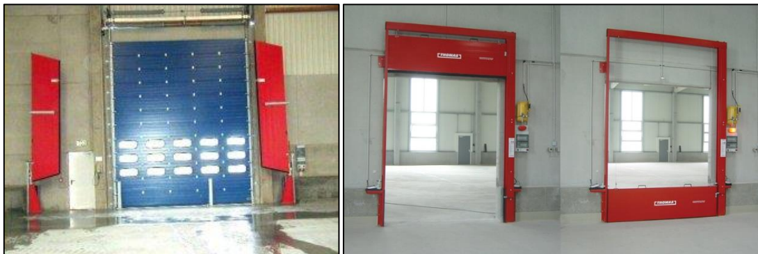
Figure 18 : Exemples de types de batardeaux (ou barrières étanches) existants pour la rétention d'effluents en interne
