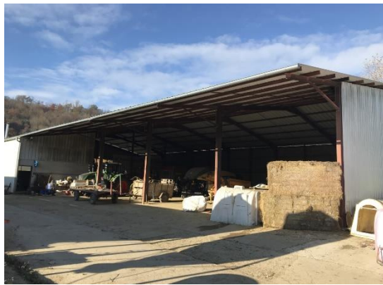
Figure 7 Bâtiment de stockage
