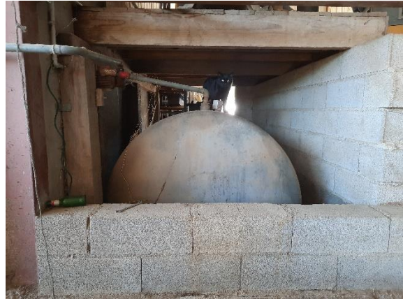
Figure 10 Cuve à fioul
