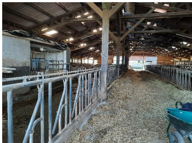
Figure 2 Vue intérieure du bâtiment des vaches laitières et des génisses
