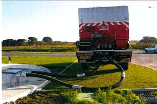
Plateforme d'aspiration sur une réserve d'eau enterrée équipée de deux colonnes d'aspiration de 100 mm
