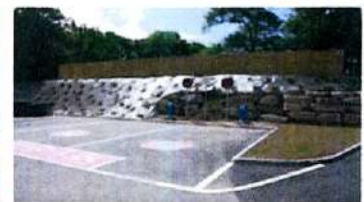
Aire d'aspiration dans une réserve artificielle (aérienne ou enterrée)
