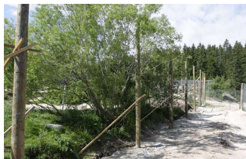
Tranchée ouverte de 30cm x 100cm et poteaux en attente de scellement
