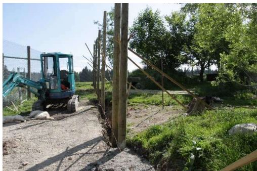
Comblement des tranchée avec du béton
