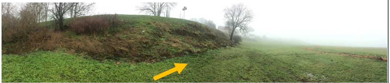
Cliché 2 – localisation prise de vue en page précédente. Noter l'absence de cours d'eau en pied de talus.
