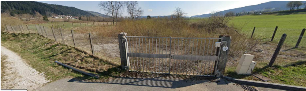
Vue depuis le Sud – Cours de la station d'épuration actuelle
