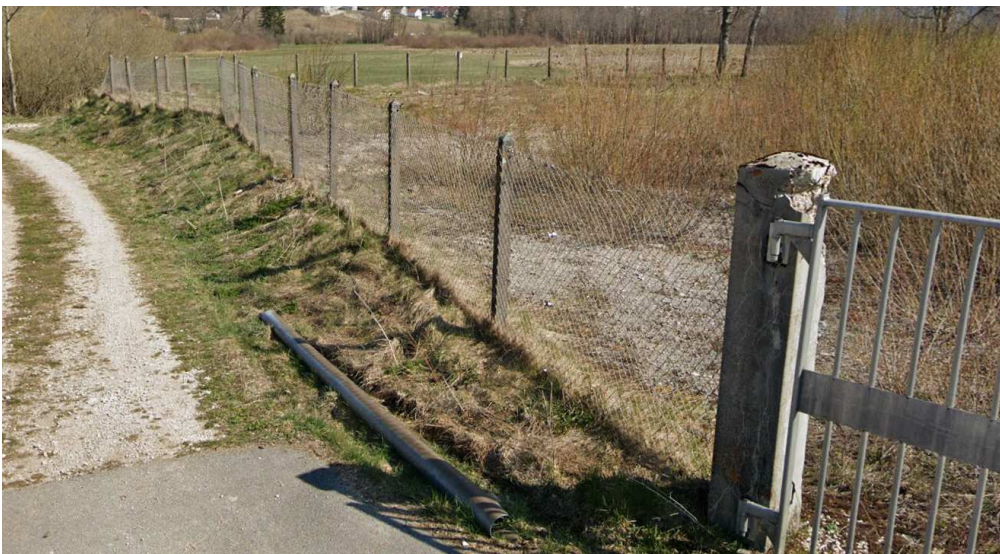
Vue depuis le Sud – Cours de la station d'épuration actuelle
