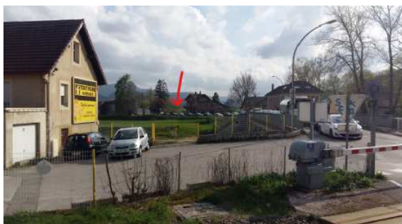
Retenue de véhicules lors de la fermeture du passage à niveau
