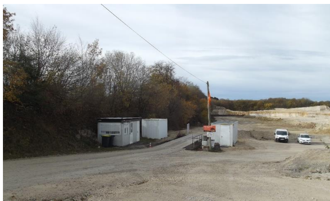
Photographie 10 : Ligne téléphonique aérienne à l'entrée de la carrière
