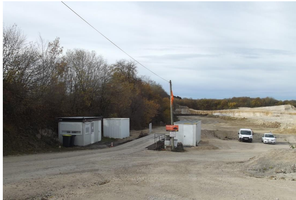
Photographie 5 : Bureaux - Bascule et parking à l'entrée de la carrière
