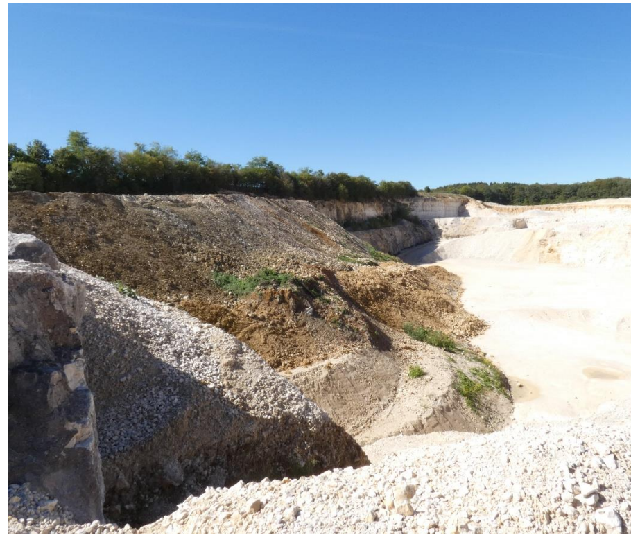
Photographie 3 : Zone en cours de remblaiement le long du front de taille Sud de la fosse Ouest
