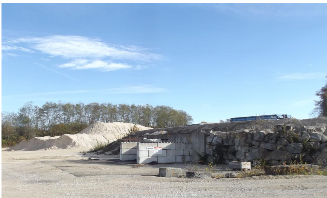
Photographie 12 : Plateforme étanche
