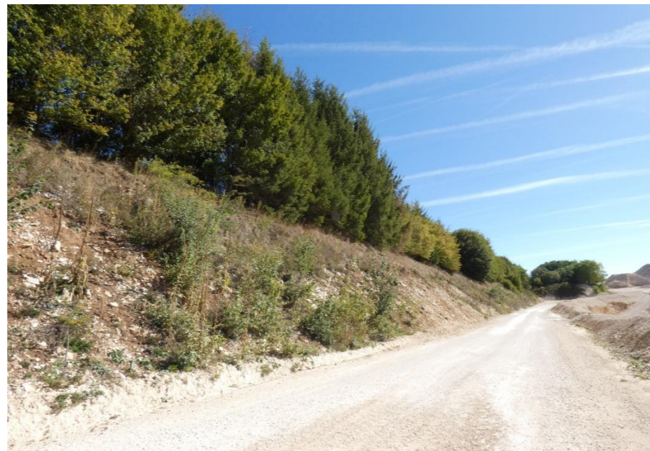
Photographie 6 : Piste interne au Nord de la fosse Ouest et merlon périphérique
