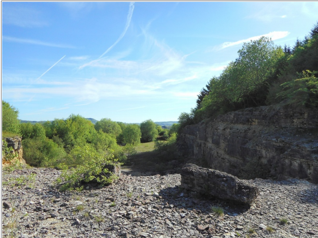
PLATEFORME SOMMITALE A SECURISER PAR UN MERLON
