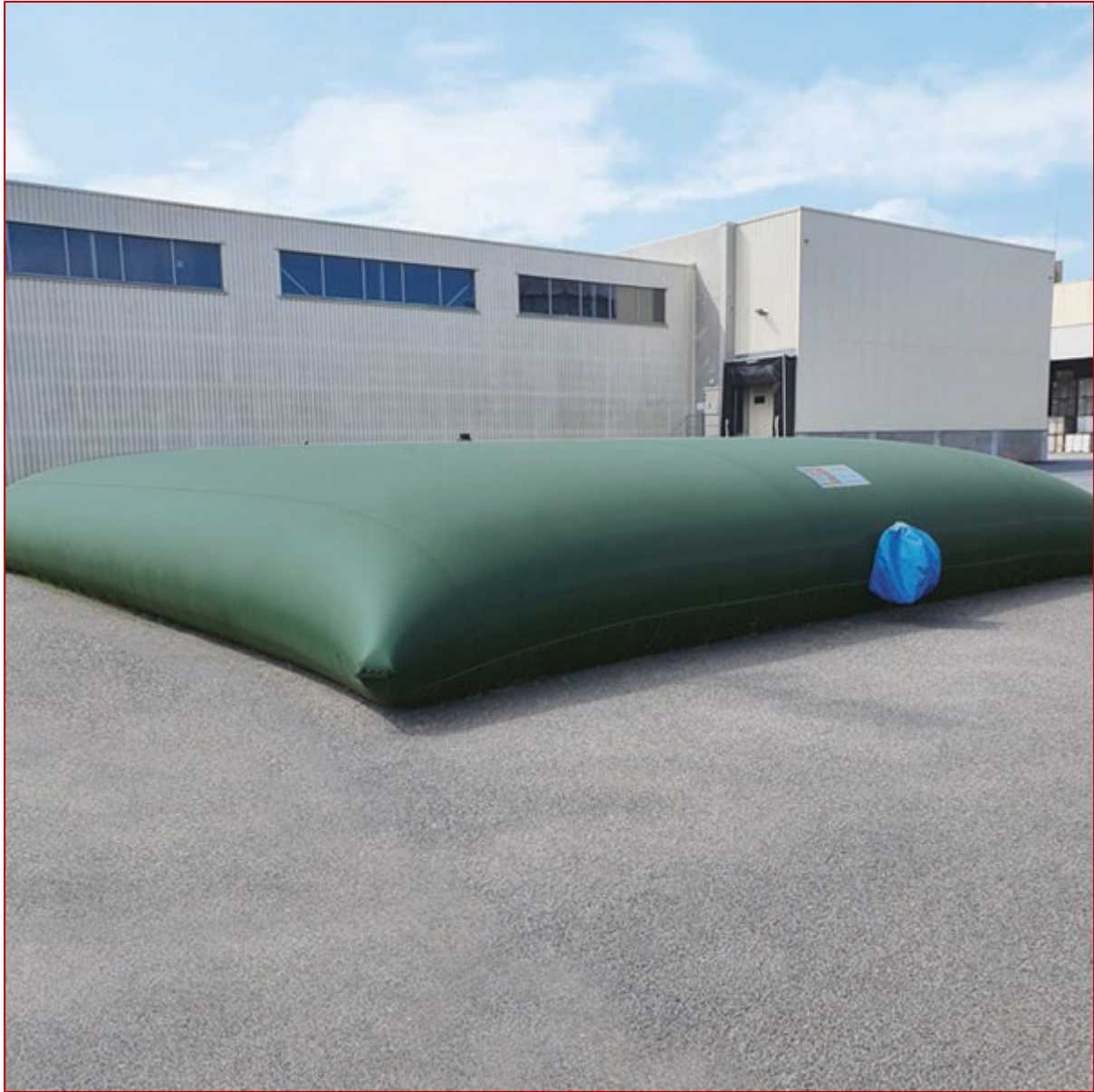
Figure 39 : Illustration réserve incendie en citerne souple – 200 m 3
