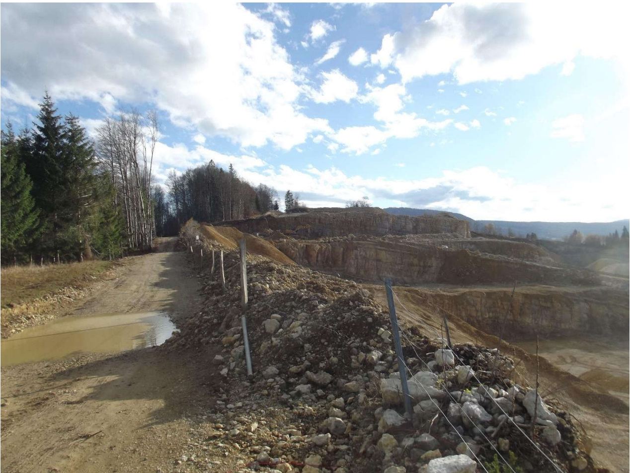
Photographie 6 : Vue sur la zone d'extraction depuis la limite Est
