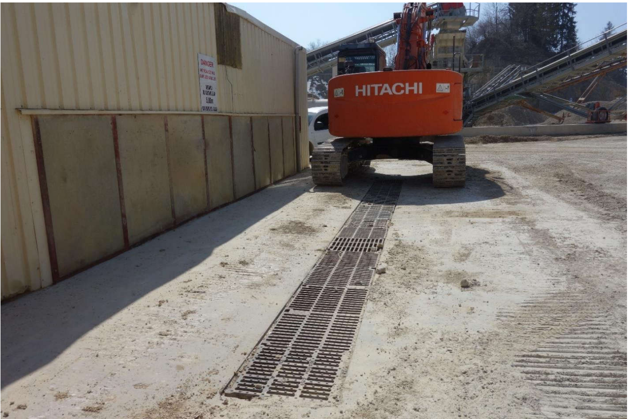
Photographie 4 : Plateforme étanche et hangar atelier
