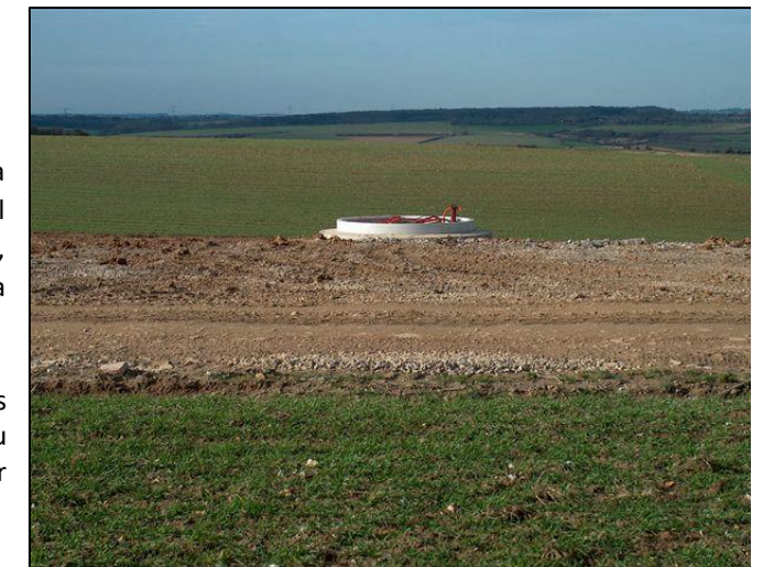
Figure 37 : Partie visible de la couronne de fixation à la surface de la fondation – Source : Cohérence Energies
