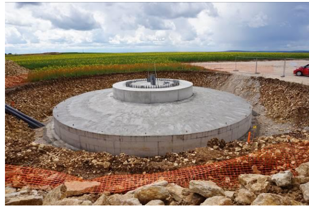
Figure 38 : Réalisation de fondation – source : Cohérence Energies
