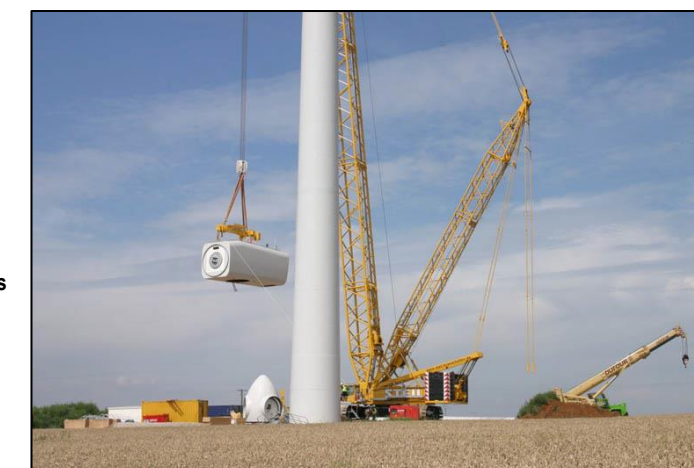
Figure 47 : Levage de la nacelle d'une éolienne – Source : Cohérence Energies
