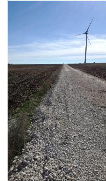
6 - Chemin d'accès achevé
