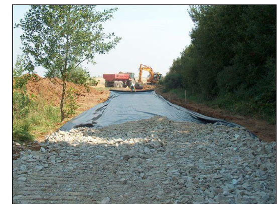
4 - Pose du géotextile
