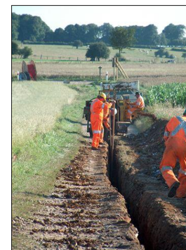
Figure 34 : Réalisation des tranchées avec enfouissement des câbles - Source : Cohérence Energies
