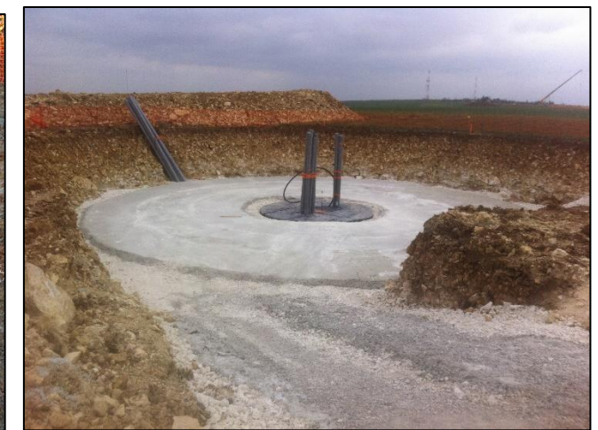
Figure 37 : Partie visible de la couronne de fixation à la surface de la fondation – Source : Cohérence Energies
