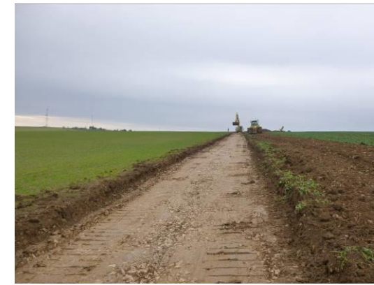
3 - Terrassement et extraction de la terre
