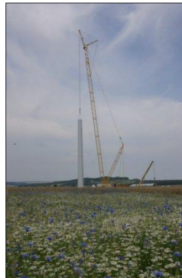
Figure 45 : Levage du mât d'une éolienne – Source : Cohérence Energies
