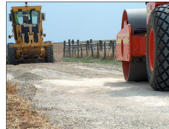
5 - Nivellement des pistes
