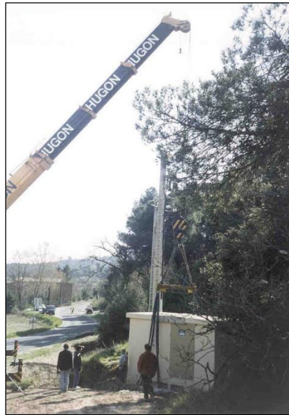
Figure 49 : Pose d'un poste de livraison – Source : Cohérence Energies
