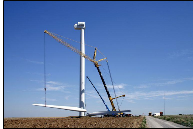
Figure 48 : Pose du rotor – Source : Cohérence Energies
