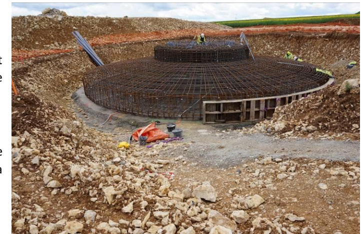
Figure 36 : Visualisation du décaissement et du ferrailage réalisés pour les fondations – Source : Cohérence Energies
