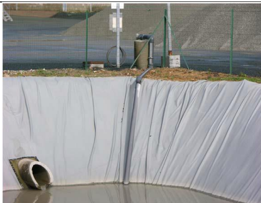
Réserve à l'air libre munie d'une colonne fixe de 100 mm
