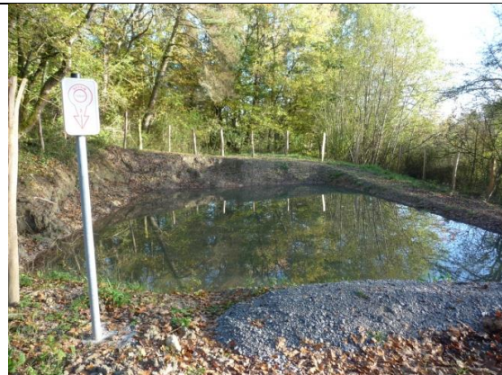
Réserve à l'air libre utilisable au moyen des aspiraux équipant les engins pompes du S.D.I.S. 25
