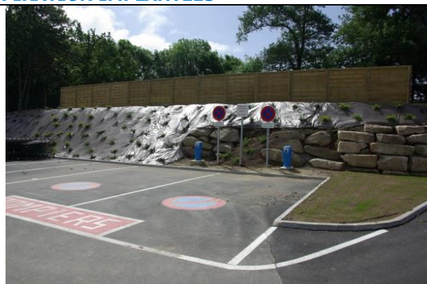
2 plateformes d'aspiration sur une réserve d'eau équipées de deux poteaux d'aspiration de 150 mm
