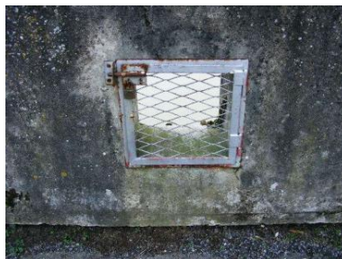
Trappe d'au minimum 40 x 35 cm permettant le passage des aspiraux des sapeurs-pompiers
